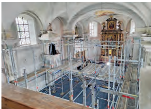
Aufbau des Innengerüstes für die Malerarbeiten.
