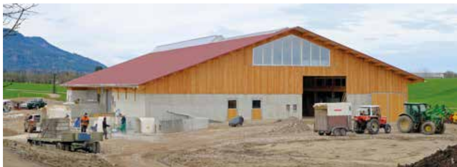
Letzte Vorbereitungsarbeiten am neuen Stall, der schon auf die Bewohner wartete
